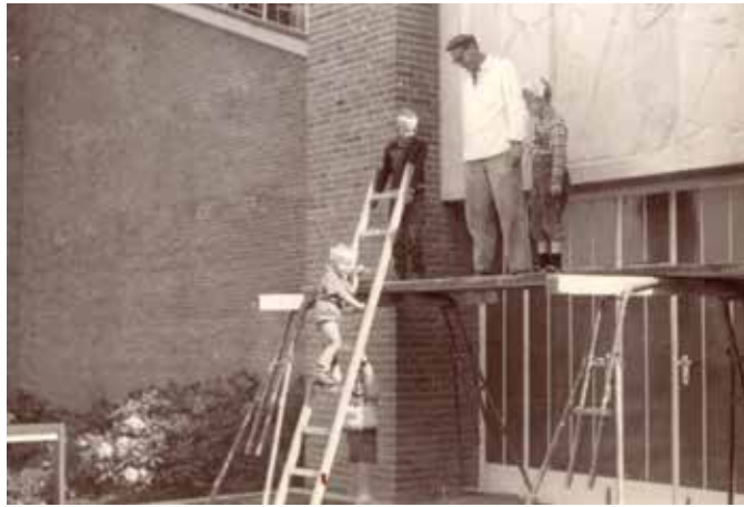
Eingangsportal St. Markus, ev., Stade Hahle. Das Ansetzen des Sandsteinreliefs „Die Lauschenden“
